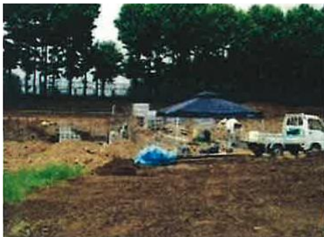
写真 7：現場に設置したテント
